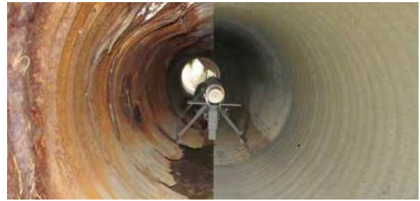
Figuur 13 Oud riool tegenover gerelined riool (Weijzen, 2013)
